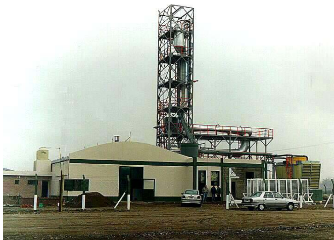
Planta de liofilización diseñada y construida por INVAP en la provincia de Chubut.
