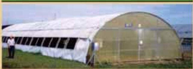
Invernadero con el techo encalado (Fuente: PHR)
