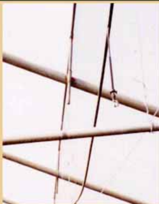
Boquilla de nebulización en el techo del invernadero (Fuente: PHR).
