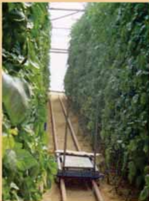
Tuberías radiantes (Fuente: PHR)
